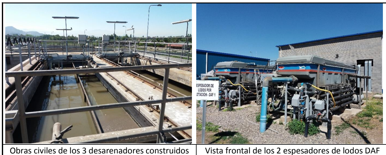
Fotografías 1.d) - 3 desarenadores y 3 espesadores de lodos DAF
