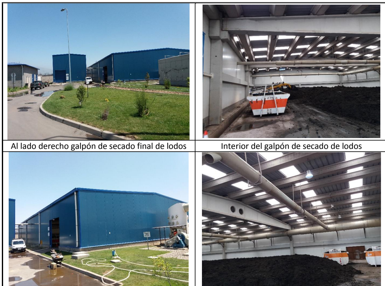
Fotografías 1.h) - Galpón de lodos cerrado, iluminado y con sistema de tratamiento de olores
