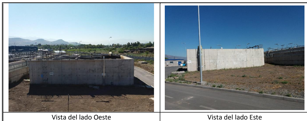
Fotografías 1.b) Estanque Selector construido de 20 m x 9,6 m. y h: 5,5 m
