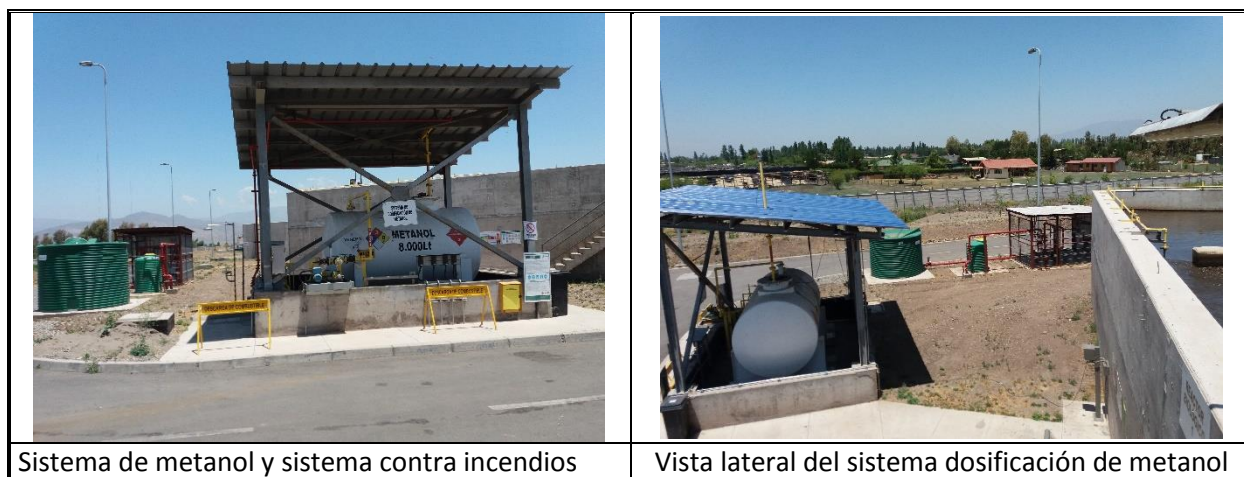
Fotografías 1.2 - Sistema de almacenamiento y de dosificación eventual de metanol
